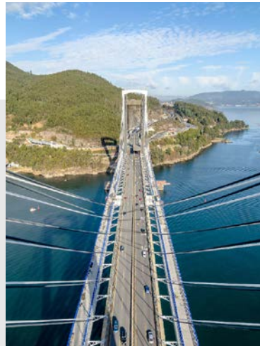
Ponte de Rande
