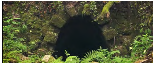
Aspecto actual da entrada do túnel do Confurco.
